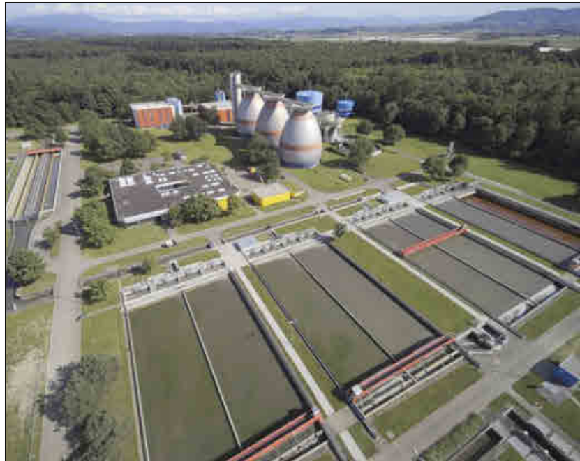
Blick über die Kläranlage Breisgauer Bucht mit den verschiedenen Klärbecken
